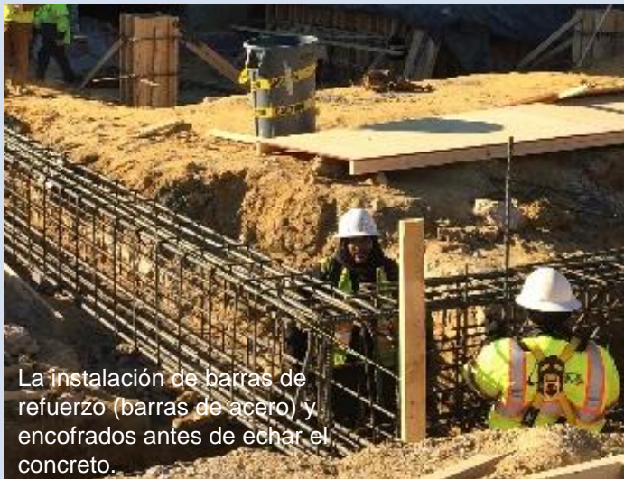
Concreto para la construcción de las fundaciones
